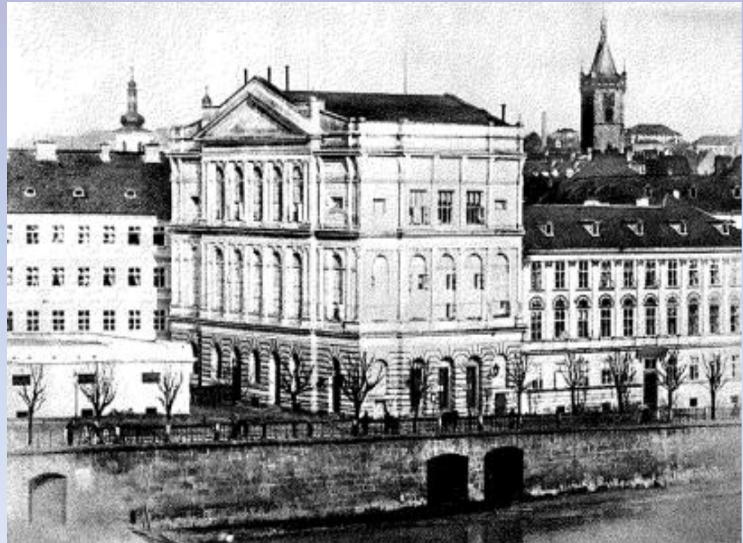
Budova Prozatímního divadla v Praze, otevřeného roku 1862
